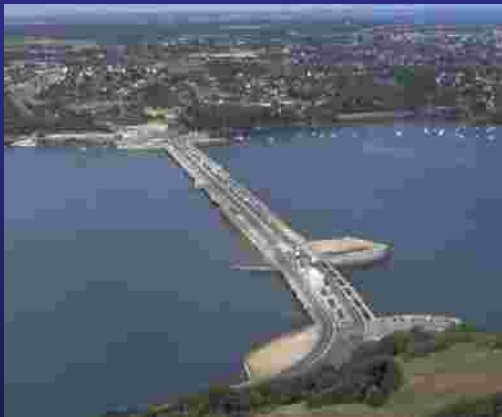
La Rance Tidal Barrage
